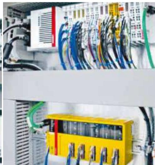
Die Sicherheitsfunktionen realisiert Borghi mit dem Twinsafe-Compact-Controller EK1960 (unten) sowie zusätzlichen Twinsafe-Klemmen, die im oberen Ethercat-Klemmenstrang integriert und direkt an den Embedded-PC CX2040 angereiht sind.
