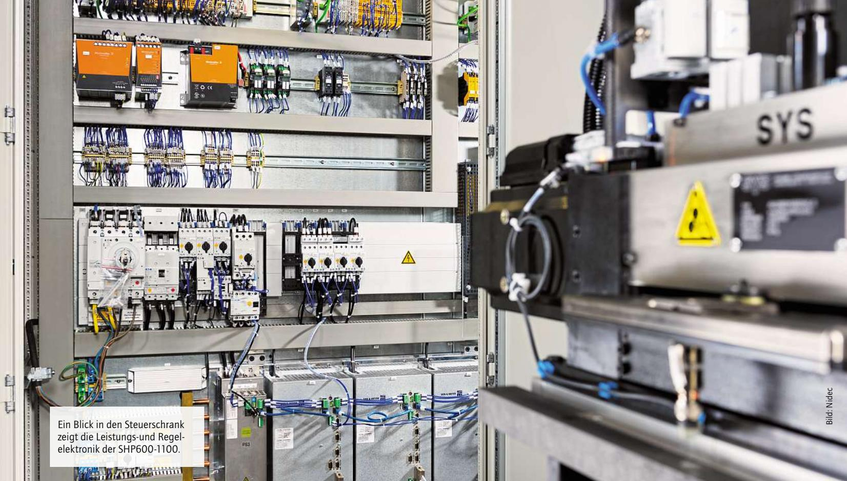
Ein Blick in den Steuerschrank zeigt die Leistungs- und Regel-elektronik der SHP600-1100.
