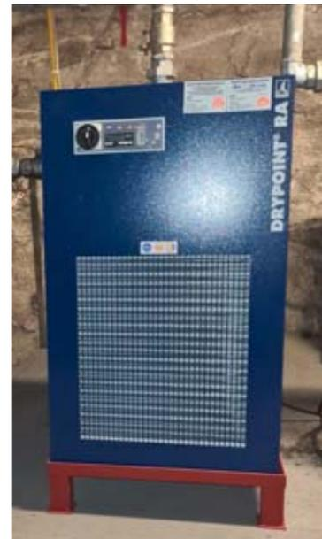
Das deutsche Bergbauunternehmen produziert unter Tage Beton für das Verfüllen aufgegebener Stollen. Die Druckluft zur Steuerung der dabei verwendeten Maschinen wird nicht von der Oberfläche zugeführt, sondern ebenfalls an Ort und Stelle erzeugt sowie aufbereitet. Allerdings führten die harten Umgebungsbedingungen immer wieder zu Ausfällen der zur Entfeuchtung eingesetzten Kältetrockner.
