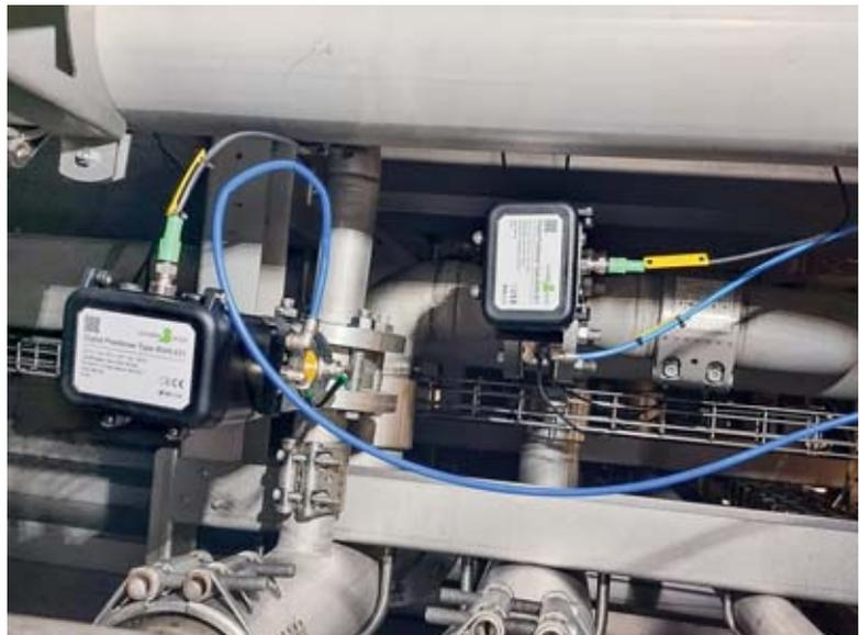
Im Zusammenspiel mit den anderen Komponenten im Tunnelpasteur sorgen Gleitschieberventile mit IO-Link von Schubert & Salzer für lange Haltbarkeit der Qualitätsprodukte von Rhodius.
