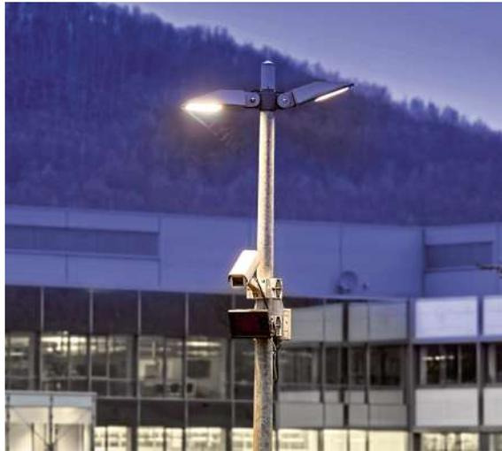
100 Meter Kabellänge meist nicht aus. Mit G.hn hingegen lassen sich auch weit entfernt montierte Kameras mit hohem Bandbreitenbedarf ins Netzwerk integrieren und mit Energie beliefern.
