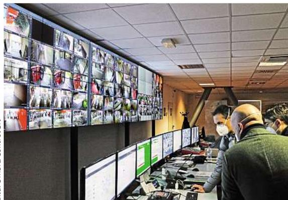
Etwa 1.500 Ein- und Ausgänge werden über rund 20 Beckhoff-Controller und zusätzliche Remote-I/Os zur Zentrale sicher übertragen und dort mit der Scada-Software Visiosuite überwacht und gesteuert.
