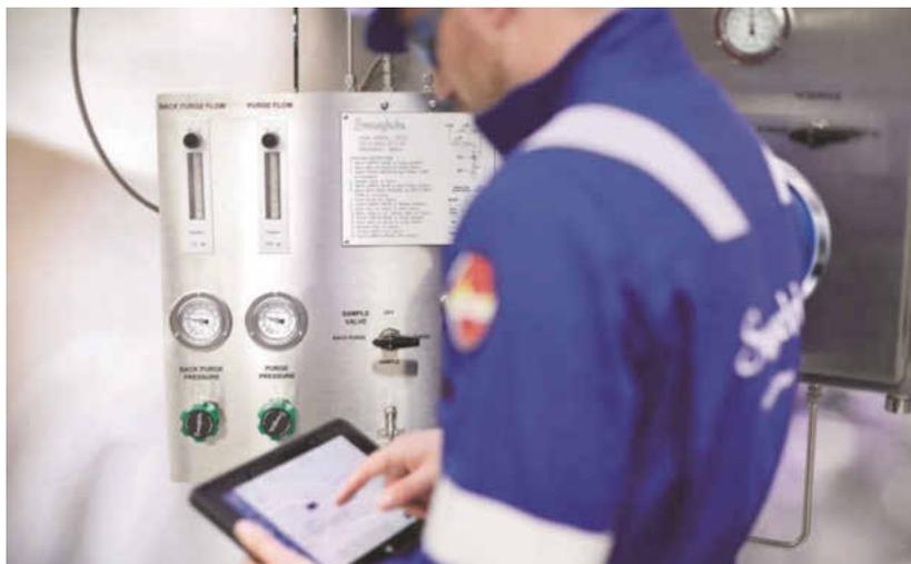
Zur Vereinfachung der Probenahme und der Wartung des Probenahmesystems ist es hilfreich, Probenahmepanels mit eingravierten Hinweisen zu verwenden, die Betriebsanweisungen und Informationen zur Bestellung von Ersatzteilen enthalten
