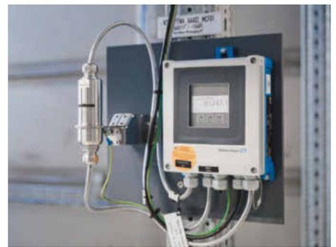
Der WirelessHart-Adapter FieldPort SWA50 (links im Bild) kann in Bestandsanlagen nachgerüstet werden und bringt Messgeräte in die Cloud
