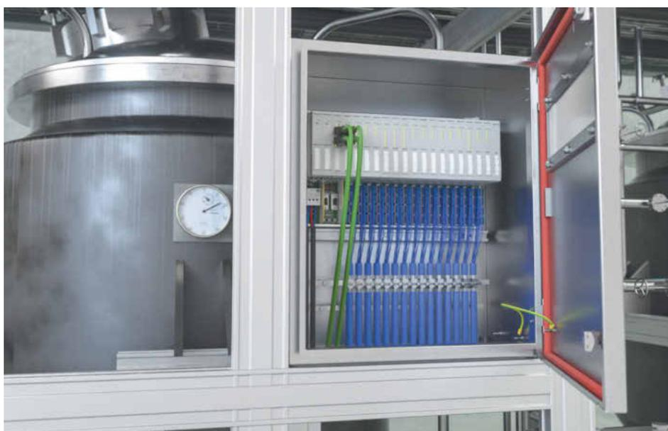
Für den Einsatz in Ex-Bereichen steht die Excom-I/O-Familie zur Verfügung. Sie unterstützt mit den jüngsten Ethernet-Gateways auch die drei Multiprotokoll-Netzwerke.
